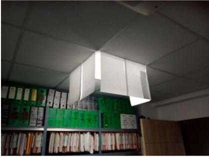
*Adaptation par un agent d'un pavé lumineux du Polygone « ABCDE » pour atténuer la luminosité excessive*
